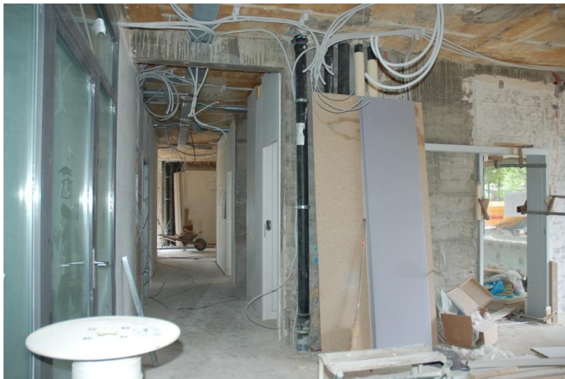
Das Müze im Umbau
